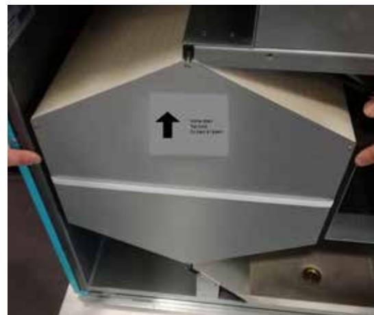
**Hinweis:** Damit der Enthalpietauscher leichter eingepasst werden kann, ölen Sie die Dichtungslippen sowie die seitlichen Dichtgummis vor dem Einpassen mit Hilfe eines weichen Tuches. Der Schmierstoff muss harz- und säurefrei sein.
